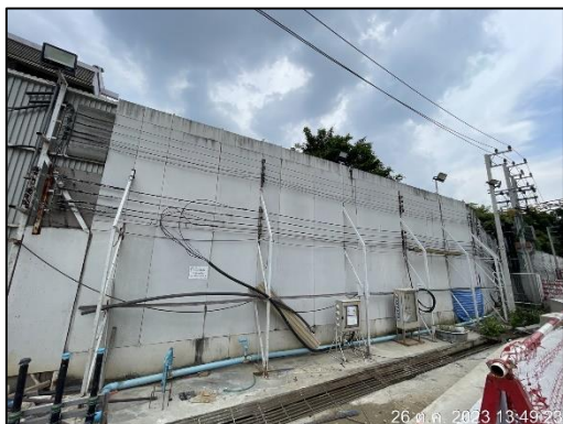
ภาพที่ 10 (ต่อ) กำแพงกันเสียงชนิด Bloxteg 2 Tuff Series
