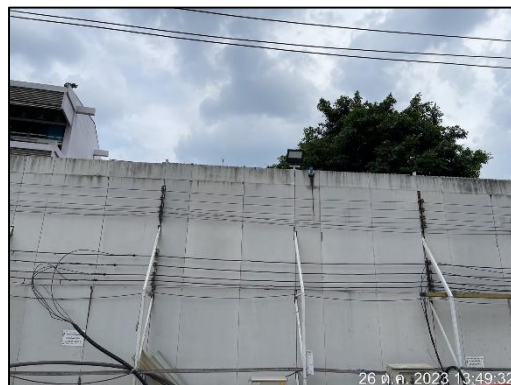
ภาพที่ 10 กำแพงกันเสียงชนิด Bloxteg 2 Tuff Series
